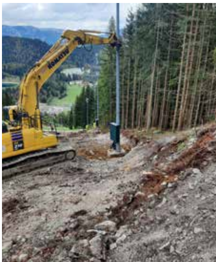
Versetzung der Lichtmasten © Bergbahnen Semmering
