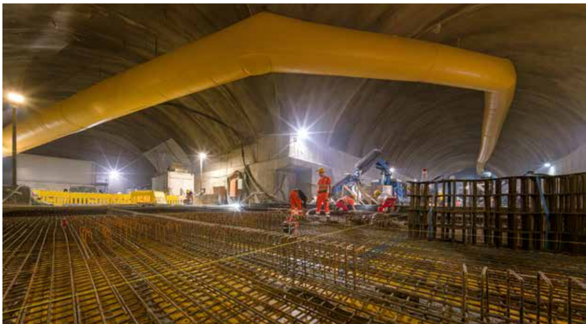
Arbeiten im Tunnel © ÖBB/Ebner
